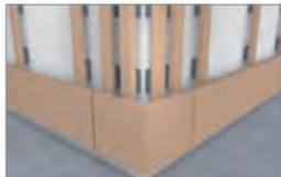
Ausgehend vom Eckelement, anschließend die unteren Wandelemente anbringen. Zwischen den Fugen 10 mm Abstand einhalten.
