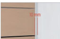
Bei Anschluss an ein anderes Bauwerk ist ebenfalls eine Dehnfuge von 10 mm einzuhalten.
