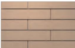
Wir empfehlen die Bildung von versetzten Fugen. Die Fugenflucht kann dabei wesentlich sauberer ausgeführt werden und Einbautoleranzen sind weniger leicht erkennbar.
