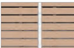
Bei durchgehenden Fugen empfehlen wir die Abdeckung der Fuge. Dies kann mit handelsüblichen Aluminium T-Schienen erfolgen. Unterschiedliche Längenänderungen können ansonsten zu einem leicht ungleichmäßigen Fugenbild führen.
