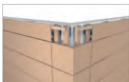
Das oberste Eckelement bzw. Wandelement auf Breite schneiden und anbringen. Falls die oberste Aufhängung weggeschnitten wurde, die Elemente mit Schrauben an der Traglattung befestigen. Evtl. ein Ausgleichsstück verwenden, um das Kippen zu verhindern.
