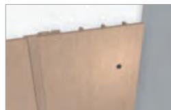
Das abschließende Profil, falls nötig, auf Breite schneiden und am Rand verschrauben. Die Verschraubung sollte in der Nähe des rückwärtigen Stegs angebracht werden um ein evtl. Durchbiegen zu vermeiden.
