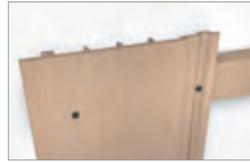
Die erste Schraube an der Seite des Profils anbringen. Die Verschraubung sollte in der Nähe des rückwärtigen Stegs angebracht werden, um ein evtl. Durchbiegen zu vermeiden. Die zweite Schraube in der Nut des Profils anbringen.
